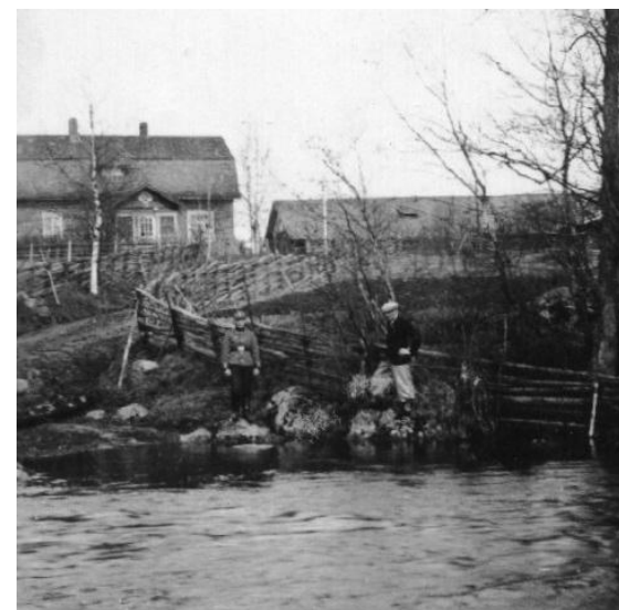
Leinon vanha talo paloi 1916 ja tilalle rakennettiin uusi. Kuvassa uusi Leinon talo Haapajärvellä.
